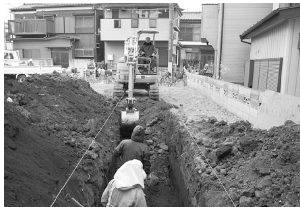
北野遺跡第 22 地点調査風景
