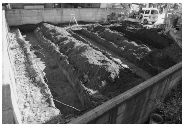
北野遺跡第 25 地点全景
