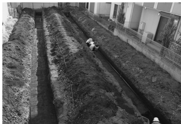
北野遺跡第 24 地点調査風景
