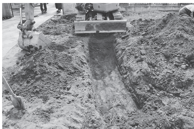
北野遺跡第38地点調査風景
