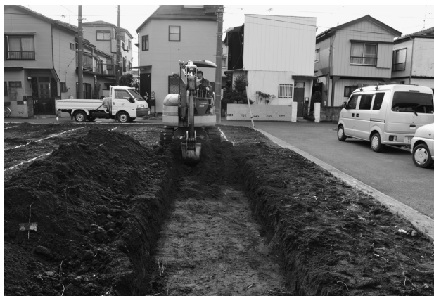
北野遺跡第 33 地点試掘調査風景
