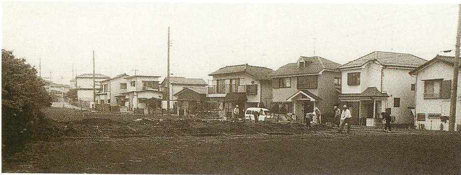
川崎遺跡の 試掘調査風景 (北より)
