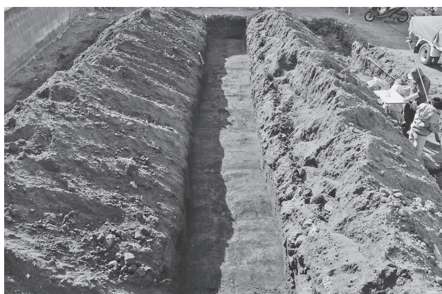
川崎遺跡第 45 地点トレンチ 2
