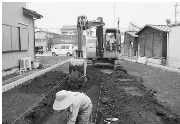
ハケ遺跡第 10 地点調査風景
