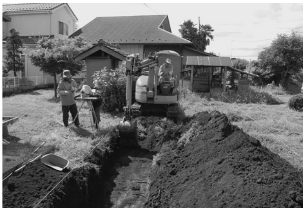
川崎遺跡第 37 地点調査風景
