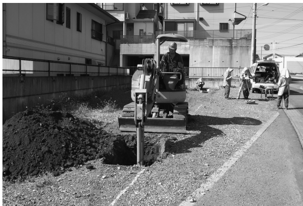
ハケ遺跡第 13 地点調査風景
