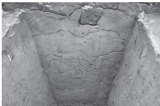
本村遺跡第 134 地点基本土層
