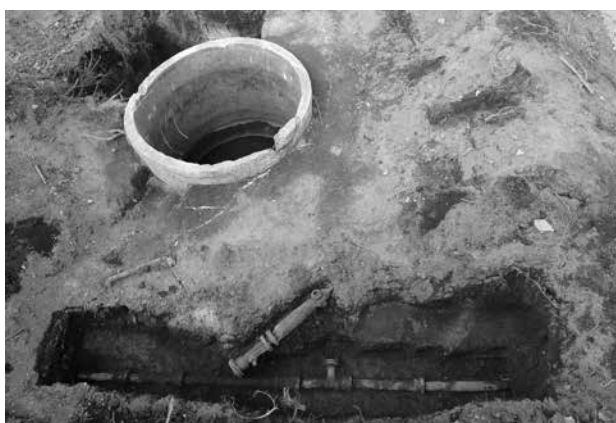
火工廠 水溜 8・消火栓 2
