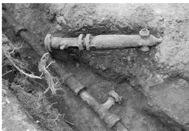
火工廠 消火栓 2
