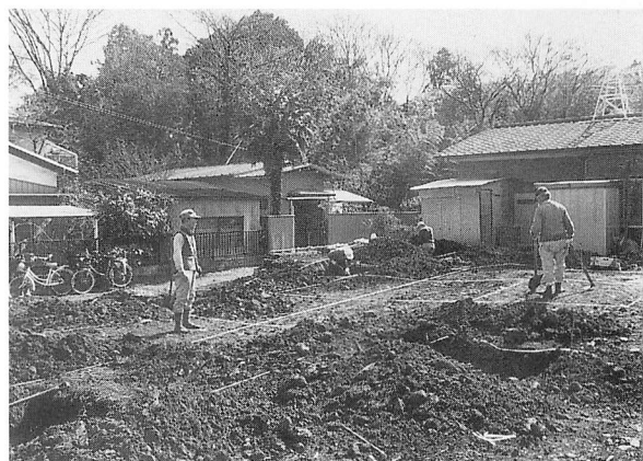
川崎遺跡 試掘調査作業風景（北より）
