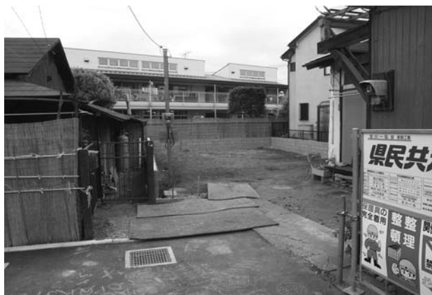
長宮遺跡第27地点試掘調査近景
