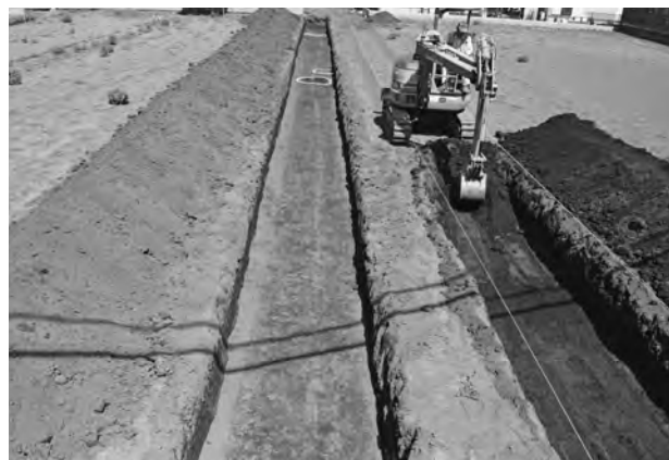
長宮遺跡第 44 地点試掘調査表土除去
