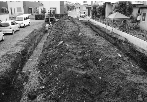
長宮遺跡第 46 地点近景
