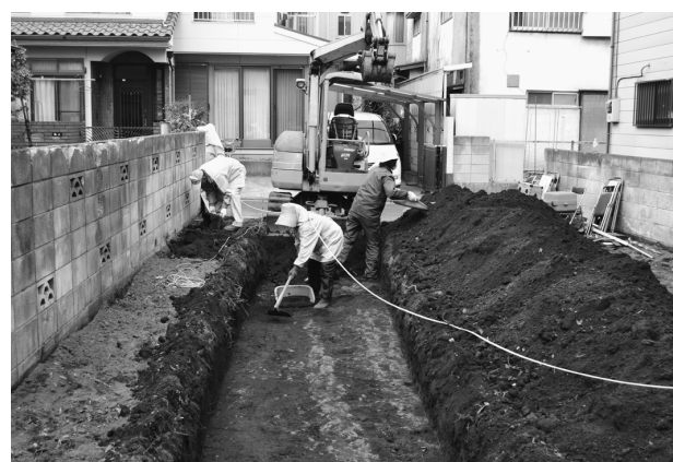
鶴ヶ舞遺跡第 19 地点調査風景
