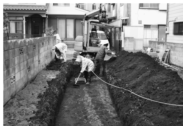
鶴ヶ舞遺跡第 19 地点調査風景
