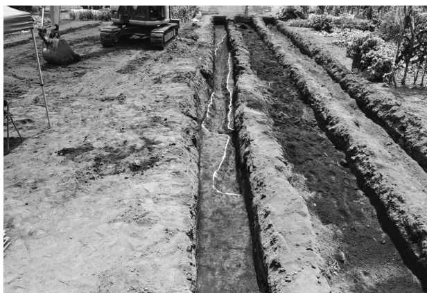
長宮遺跡第 45 地点トレンチ 3
