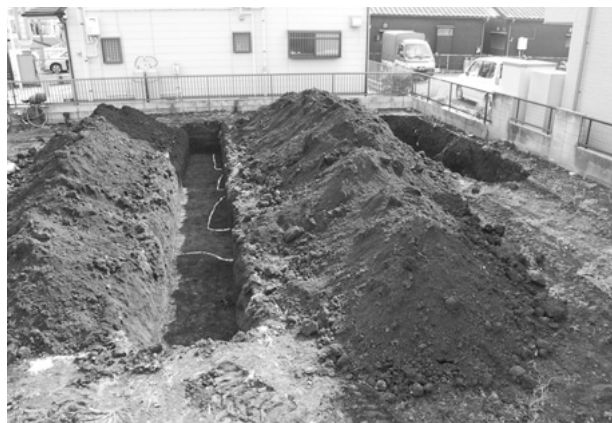
長宮遺跡第 37 地点トレンチ
