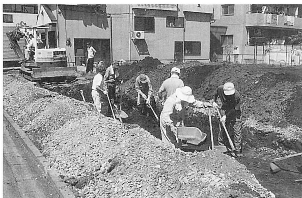
松山遺跡試掘調査(2)作業風景(南西より)
