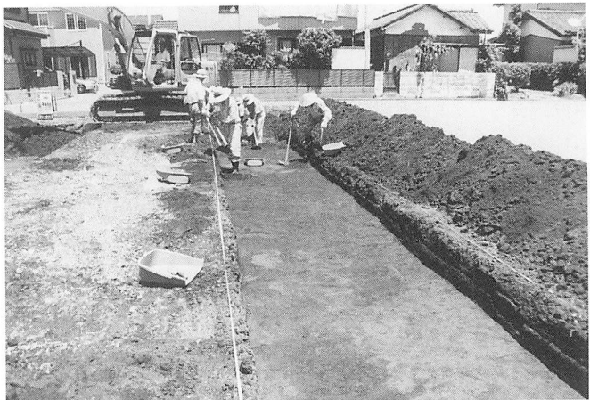
松山遺跡試掘調査(2)作業風景 (南より)
