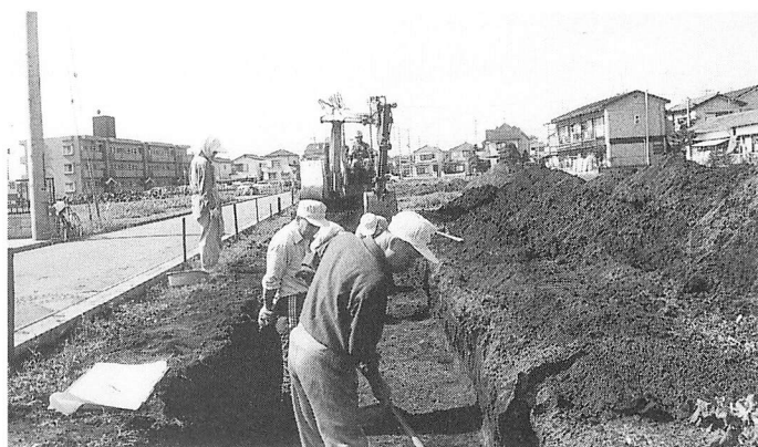
松山遺跡試掘調査(4)作業風景(東より)
