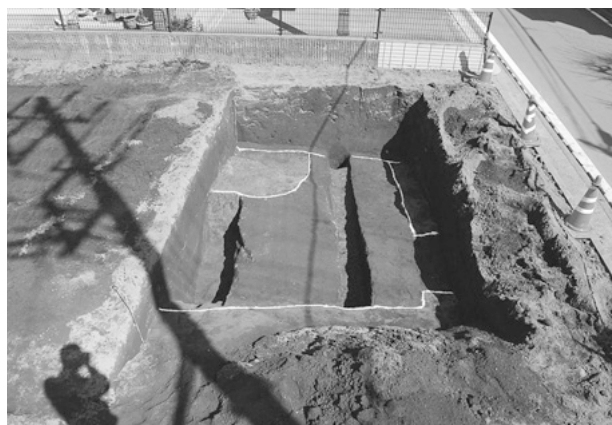
松山遺跡第 60 地点堀跡
