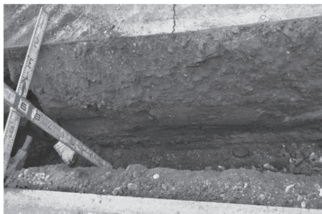
松山遺跡工事立会調査風景
