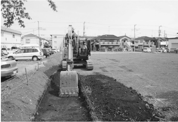
駒林遺跡第 16 地点調査風景
