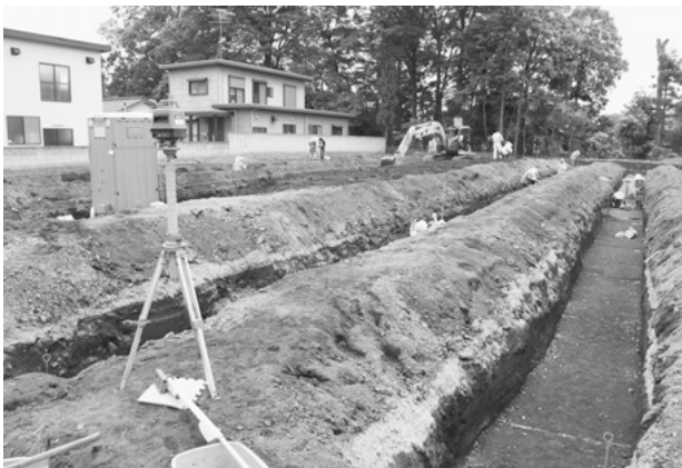
駒林遺跡第 16・17 地点調査風景
