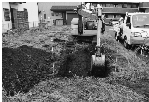
駒林遺跡第 30 地点調査風景
