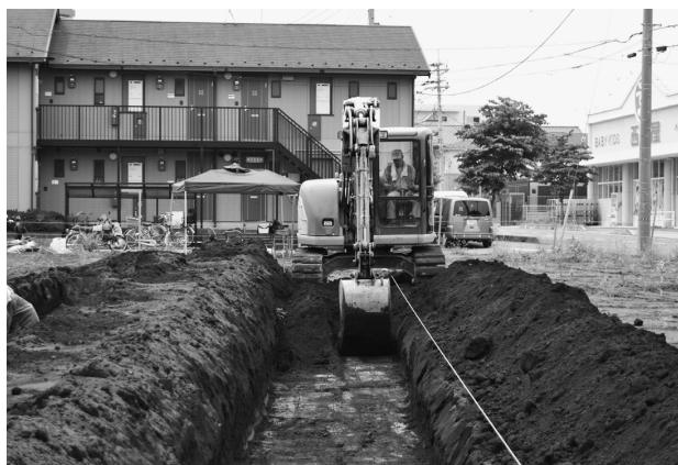
東久保遺跡第 71 地点調査風景
