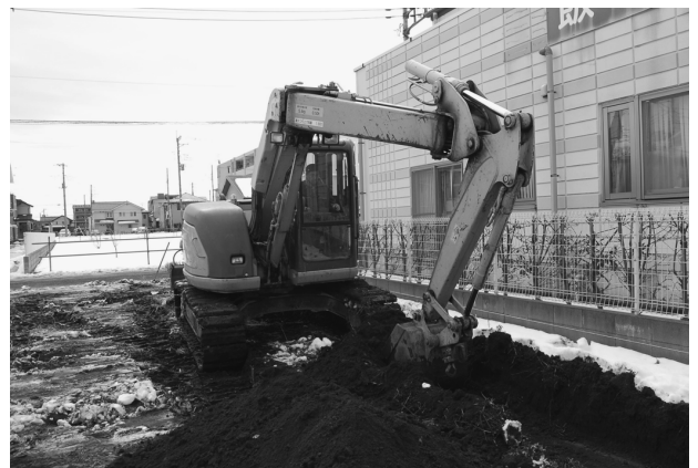
駒林遺跡第 32 地点調査風景
