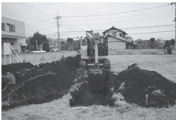
駒林遺跡第 37 地点試掘調査風景
