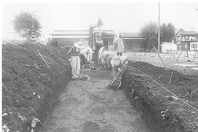
駒林遺跡試掘調査(3)作業風景 （南より）
