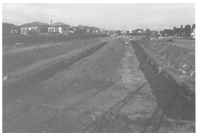
大原2丁目試掘調査（9月実施分） トレンチ表土除去作業風景（南西より）
