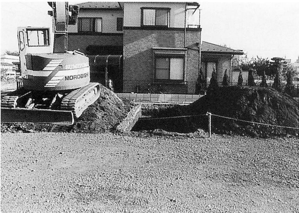
亀居遺跡第55地点調査区近景
