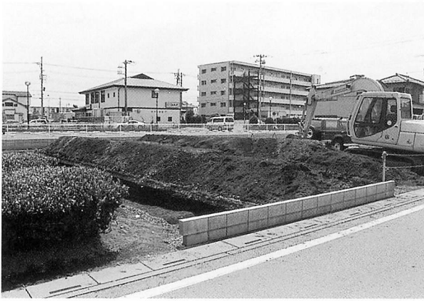
亀居遺跡第54地点調査区近景
