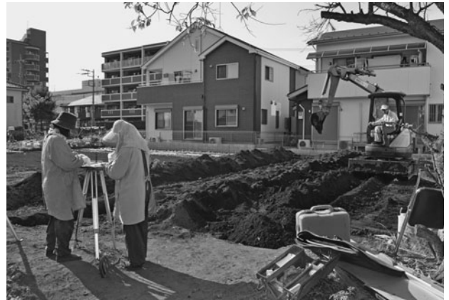
亀居遺跡第 72 地点調査風景
