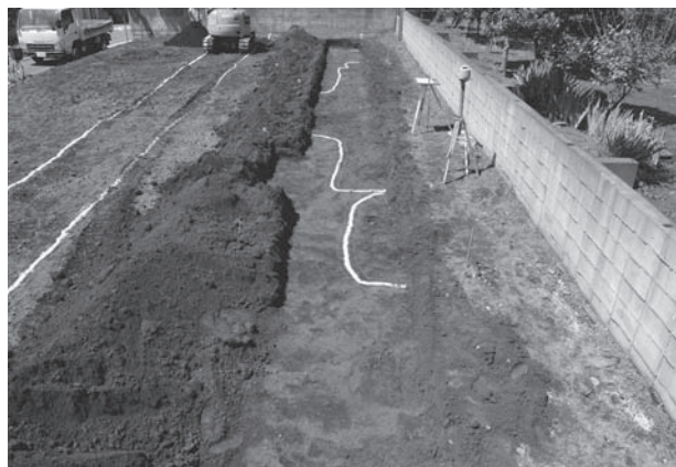
亀居遺跡第 73 地点トレンチ 1
