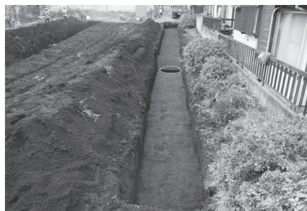
亀居遺跡第 74 地点トレンチ 4
