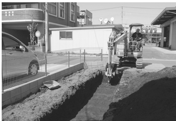
亀居遺跡第 70 地点調査風景
