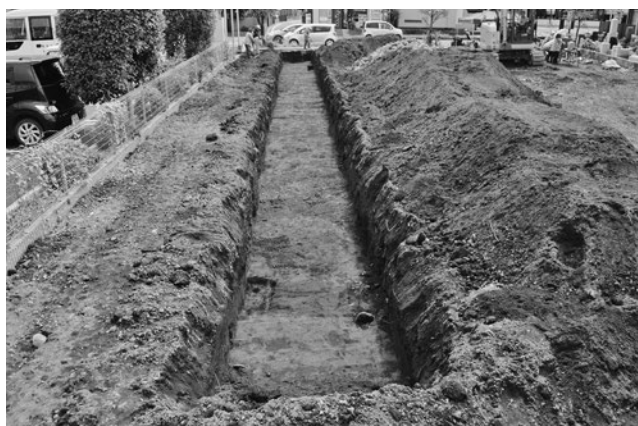
亀居遺跡第 82 地点トレンチ 1
