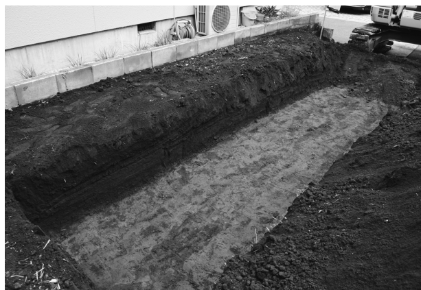
鶴ヶ舞遺跡第20地点トレンチ1
