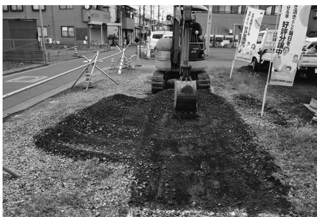
鶴ヶ舞遺跡第21地点調査風景
