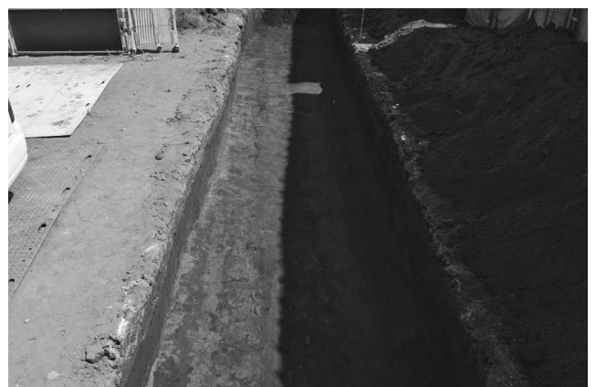
鶴ヶ舞遺跡第 32 地点トレンチ
