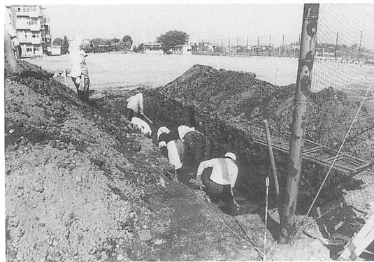
試掘調査風景
