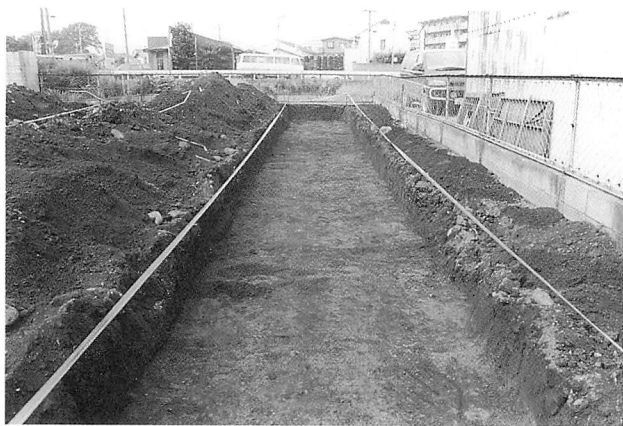
江川南遺跡第11地点試掘トレンチ1
