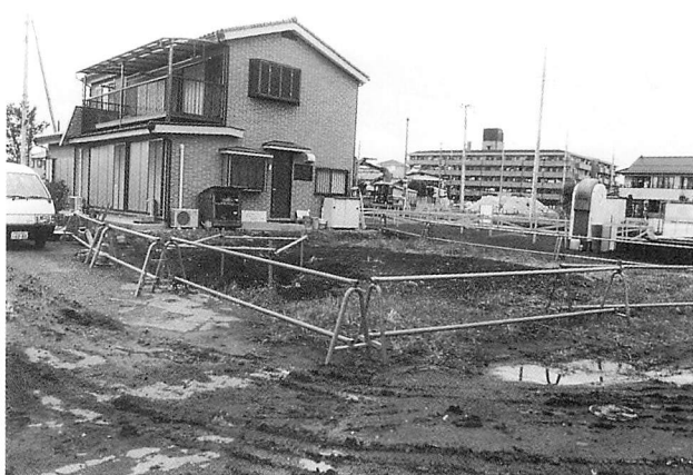
東久保遺跡第13地点試掘近景
