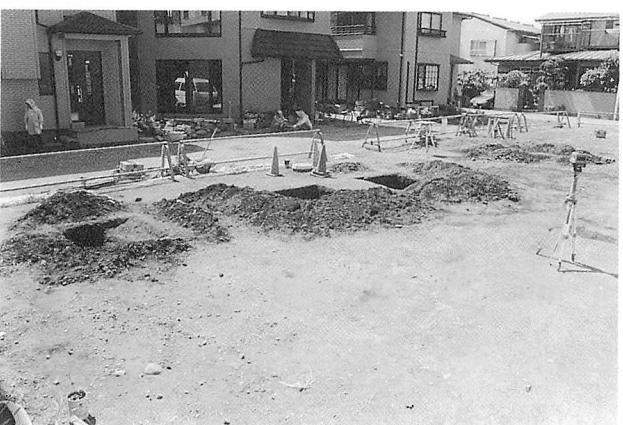
東久保遺跡第15地点試掘近景
