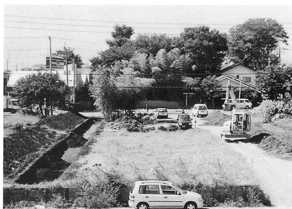
江川南遺跡第16地点試掘調査
