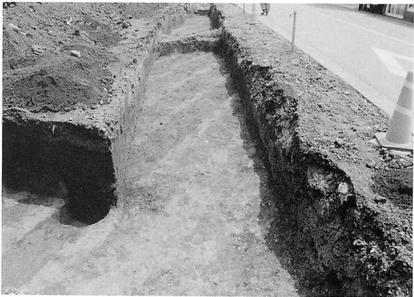
江川南遺跡第18地点試掘調査
