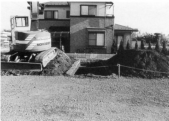
亀居遺跡第55地点調査区近景
