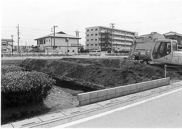
亀居遺跡第54地点調査区近景
