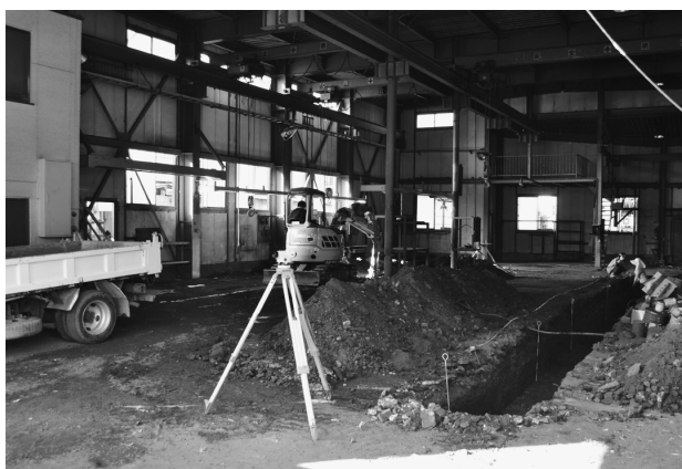
江川東遺跡第 21 地点トレンチ 1
