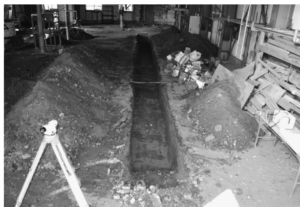
江川東遺跡第 21 地点トレンチ 1
