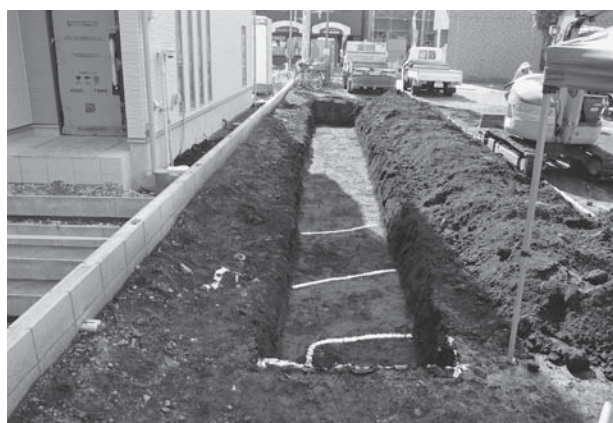
江川東遺跡第 23 地点トレンチ 1
