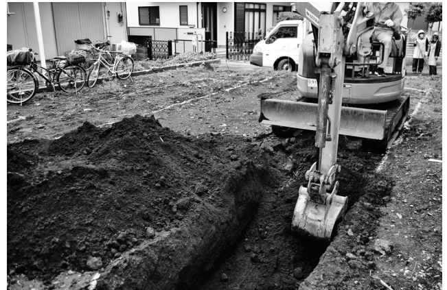
江川東第 29 地点調査風景
