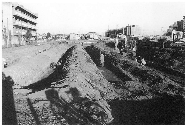
東久保遺跡第18地点試掘近景
