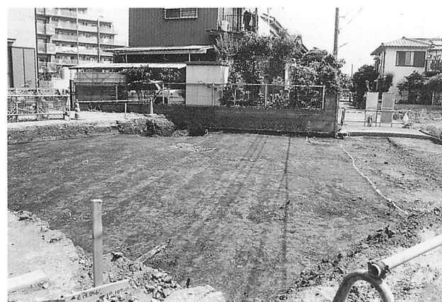
東久保遺跡第31地点調査区全景
