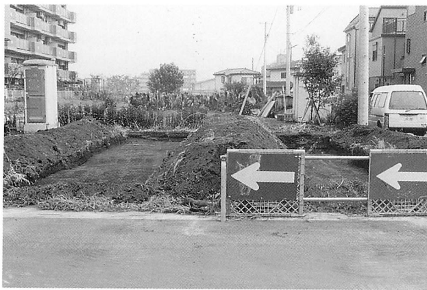
東久保遺跡第34地点調査区全景
