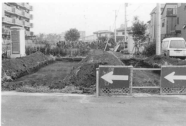
東久保遺跡第34地点調査区全景
