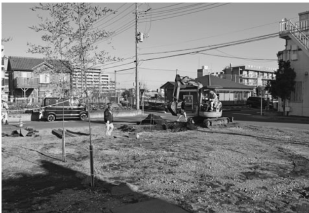
東久保西遺跡第 20 地点全景
