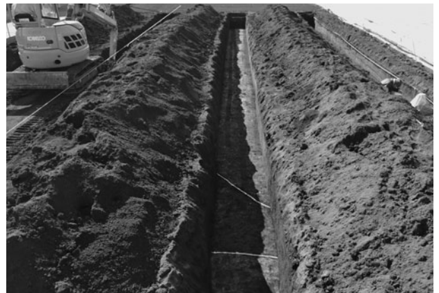
東久保西遺跡第 21 地点全景
